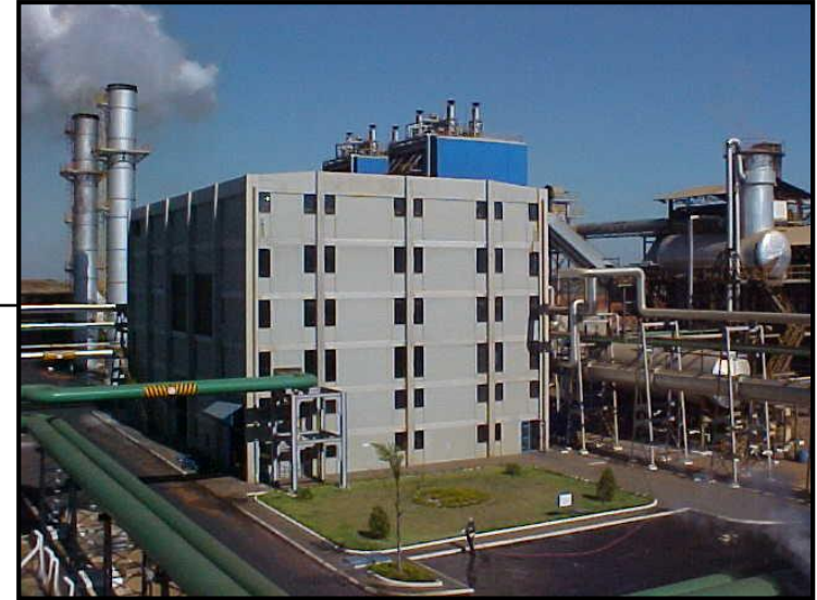
Casa de Fuerza - EQUIPAV
