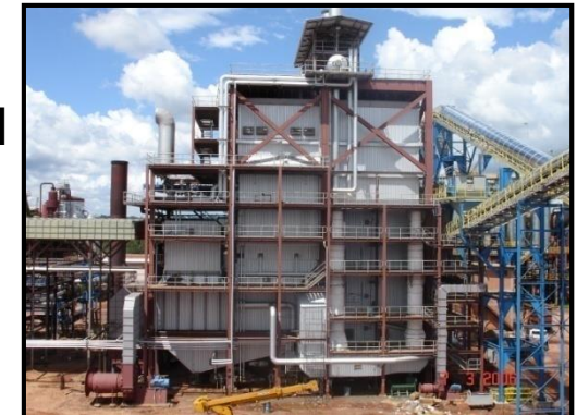
Caldera 300 TVH – 67 bar – 520°C Grupo Sta. Terezinha
